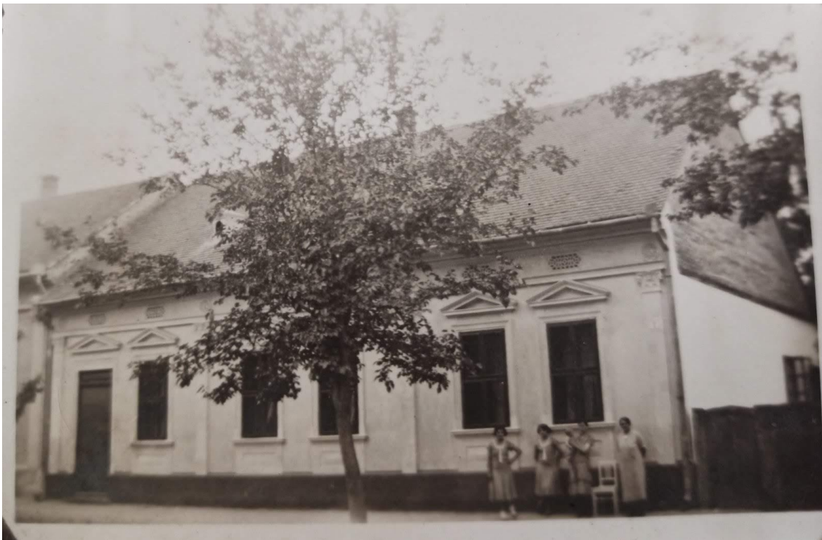
Fotografija 121. Obiteljska kuća Gérard u Nuštru
