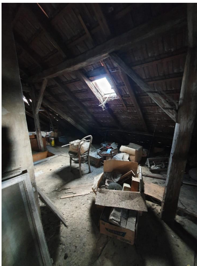
Fotografija 399. Detalj s tavana kuće u Zagrebačkoj ulici 2 u Vinkovcima 20. veljače 2020. godine (zatečeno stanje)
